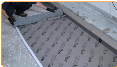
Stendere l'isolante acustico con i granuli di gomma rivolti verso il basso
