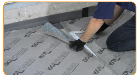
Incollare la cimosa adesiva aiutandosi con le linee di sormonto
