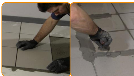
Posare la pavimentazione in ceramica o legno
