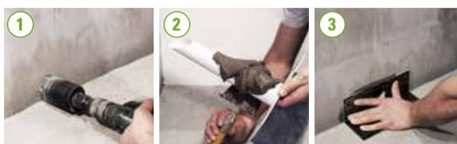
② Utilizzare Keralevel® Eco LR per il fissaggio provvisorio e il riempimento: applicare il livellante sul tubo d'uscita di Aquaform OD e nell'eventuale alloggiamento a massetto.
