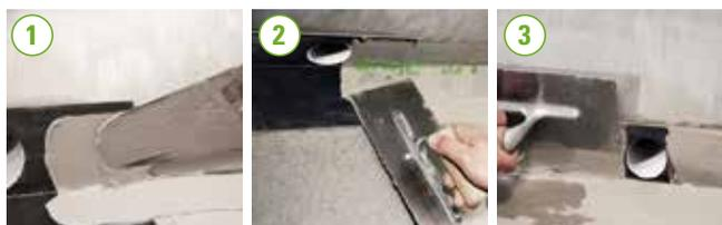
② Fissare Aquastop 70 sull'impermeabilizzante fresco seguendo il giunto parete-pavimento. Esercitare una forte pressione e lisciare per garantire l'incollaggio totale di Aquastop 70 evitando la formazione di pieghe del nastro.
