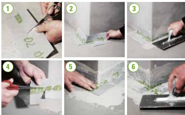
In fase di impermeabilizzazione del giunto parete pavimento sovrapporre Aquastop 70 sul pezzo speciale per circa 10 cm.
